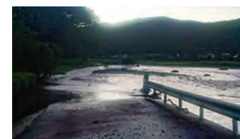
杜川氾濫の様子
